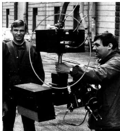
**Рис. 6.** Гиросtabilизатор ЗГСП, установленный на операторском кране [7]
